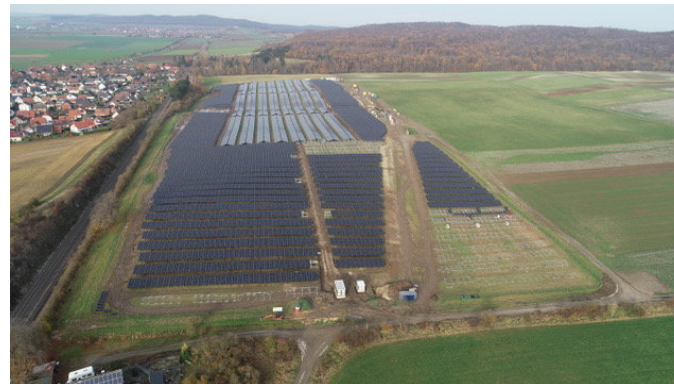
Freiflächen-PV-Anlage der Bürgerenergie Harz in Dörnten, LK Goslar, 11,1 MWp, Kapitalbeteiligung derzeit ca. 1 %
